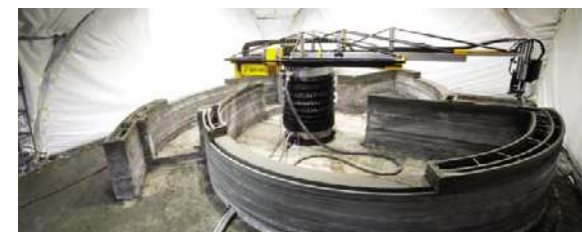
설치된 3D프린터로 건축중인 주택 <사진출처 : 한국일보>
